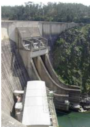
Barragem de Castelo de Bode
