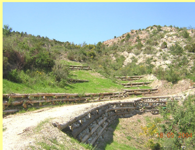
Esempio di palificate in legname a doppia parete, a 30 giorni dalla ripresa vegetativa Rio Crovetto, Spotorno (SV), maggio 2004 (foto U.Bruschini)
