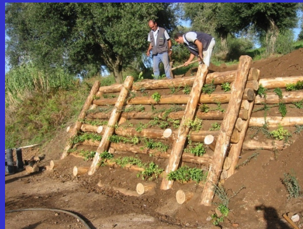
Palificata Roma -Viabilità Istituto Agrario Palmi (RC)- foto Cornelini
