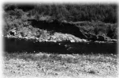
Erosão nos taludes
