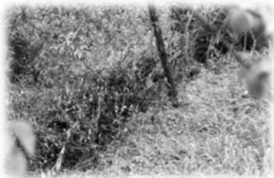
Assoreamento e obstrução das linhas de água
