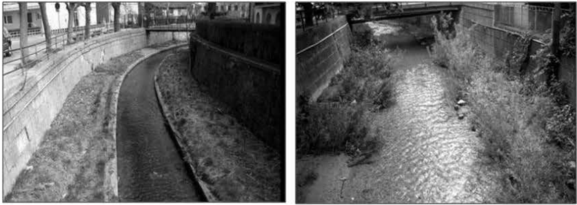
Fig. 4.25. Intervenção de renaturalização no rio Mödling (junto a Viena, Áustria) - situação original e um ano após a intervenção (Imagens cedidas por F. Florineth)
