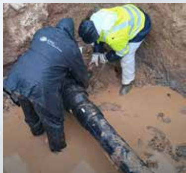
18 de fevereiro – Instalação de conduta provisória - Mosteiros – Caldas da Rainha
