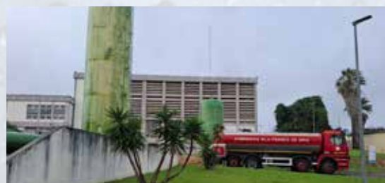
Camião cisterna a abastecer no recinto da EPAL na Castanheira do Ribatejo – Vila Franca de Xira
