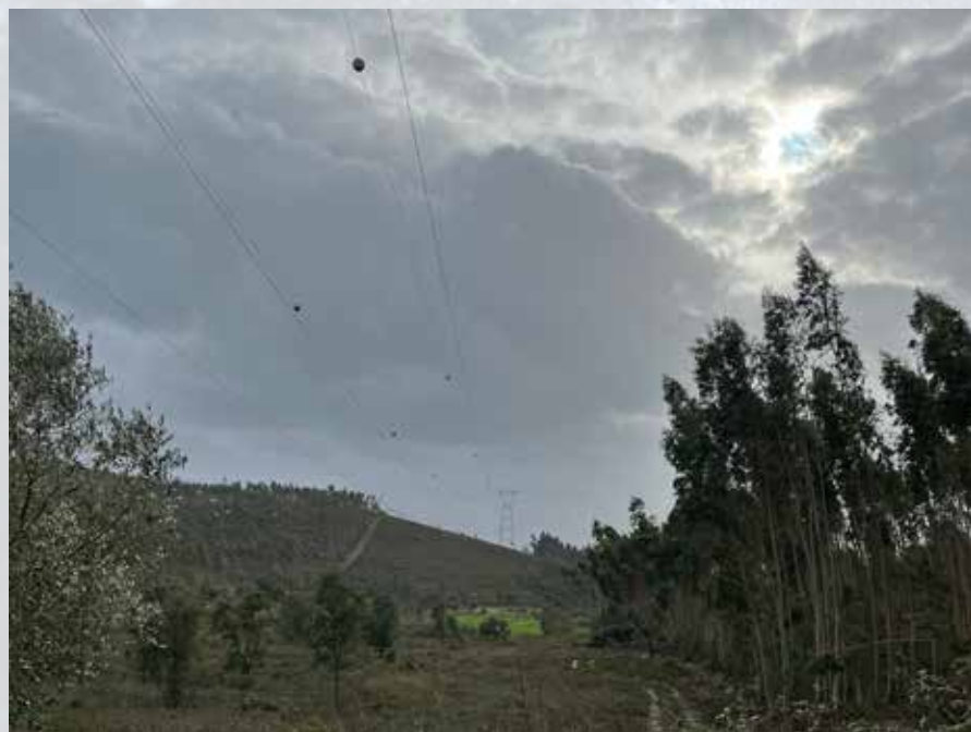
Linhas Elétricas de Média e Alta Tensão totalmente destruídas
