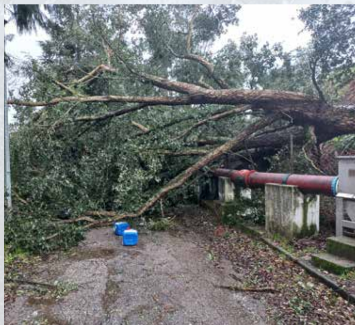
Figura 1 – ETAR Pedrogão Grande, queda de árvores nos órgãos de tratamento e acessos no recinto da instalação, 28/01/2026
