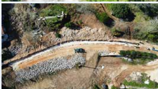
11 de março – trabalhos de reposição da conduta em Maiorga, já com a estrada reestabelecida pelo município
