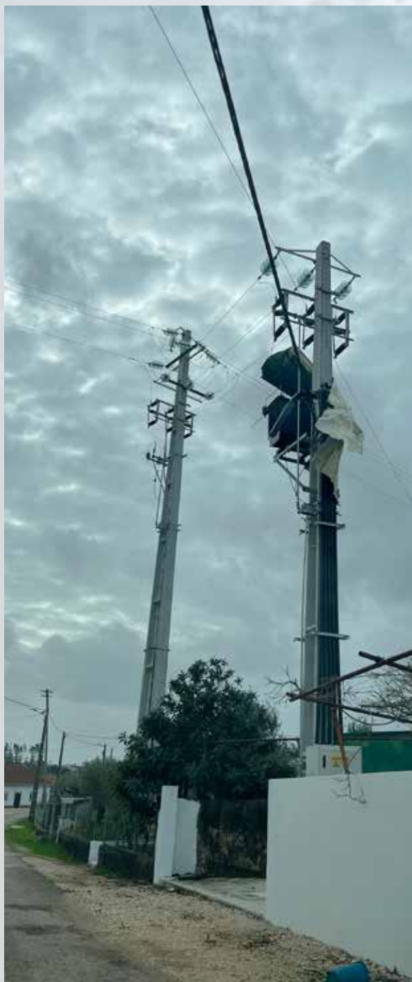
Chapas de telhados em postos de transformação públicos
