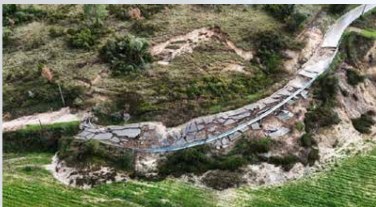
(Imagem acima) Vista da estrada de acesso à Marmeleira após o deslizamento de terras
