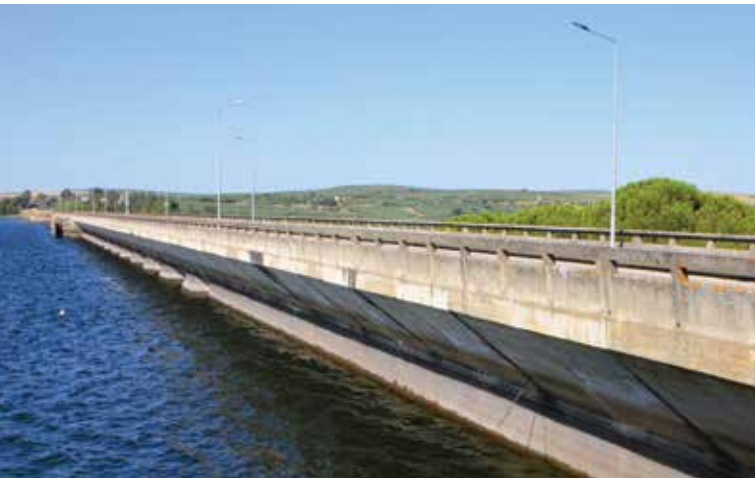
A barragem do Caia, que serve de travessia rodoviária, tem cerca de 45 metros de altura e 235 metros de cota de coroamento. A sua bacia situa-se, metade no concelho de Elvas (parte de betão) e a outra metade (parte de aterro) no concelho de Campo Maior.
