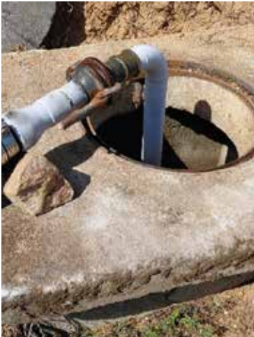
Figura 3. Injeção da pasta de gelo no troço de conduta de Malpica do Tejo
