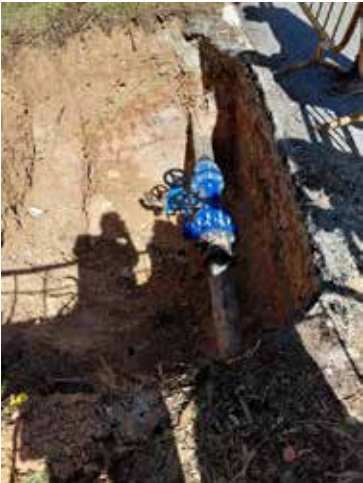
Figura 4. Instalação de válvula e acessórios no troço de conduta de Malpica do Tejo
