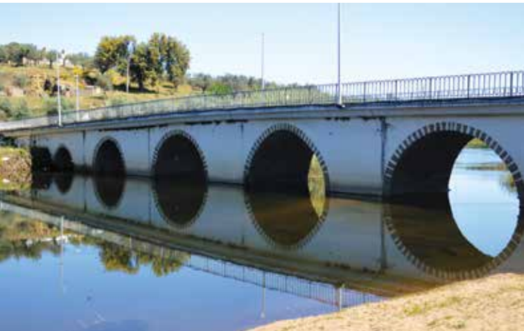
A Ponte do Crato tem 60 metros de comprimento e 7,3 m de largura. Nos dois extremos da travessia, rodoviária e pedonal, é possível saber que em 1957, a Junta Autónoma das Estradas, realizou obras de grande reparação e alargamento desta ponte sobre o rio Caia.
