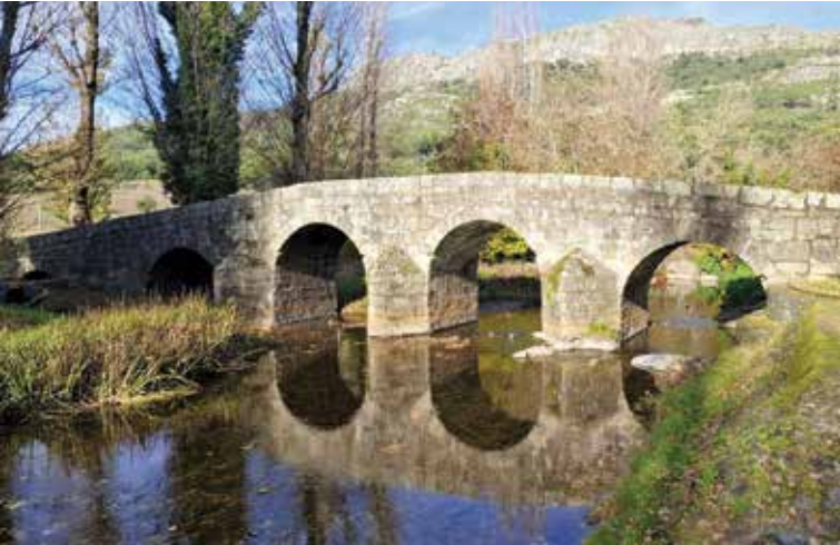
A Ponte Velha é um dos testemunhos patrimoniais mais icónicos da aldeia da Portagem e da região de Marvão. A sua travessia sobre o rio Sever é constituída por um tabuleiro em rampa, com cerca de 52 metros de comprimento e 3,8 metros de largura.
