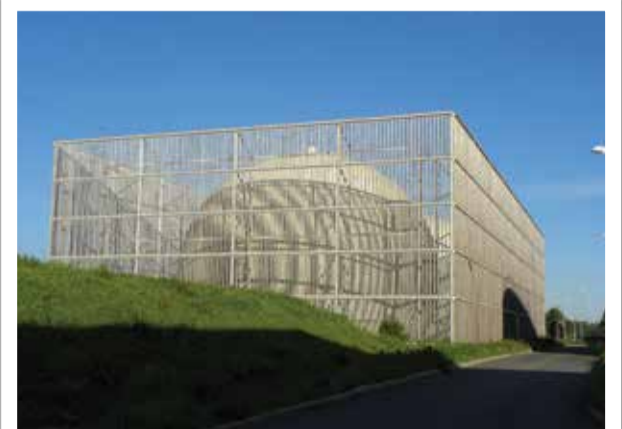
A ETAR da Guia tem um sistema de cogeração que se baseia no aproveitamento do poder calorífico do biogás
