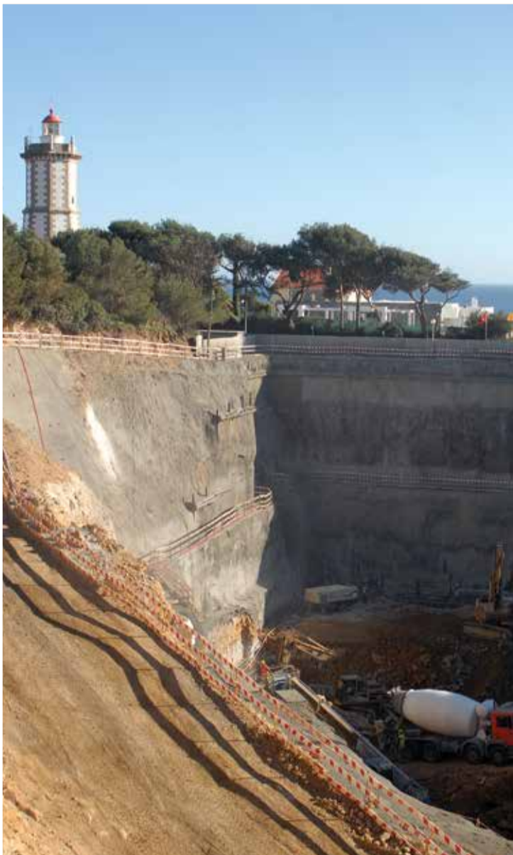
Durante a construção do novo edifício (Fase Líquida)
