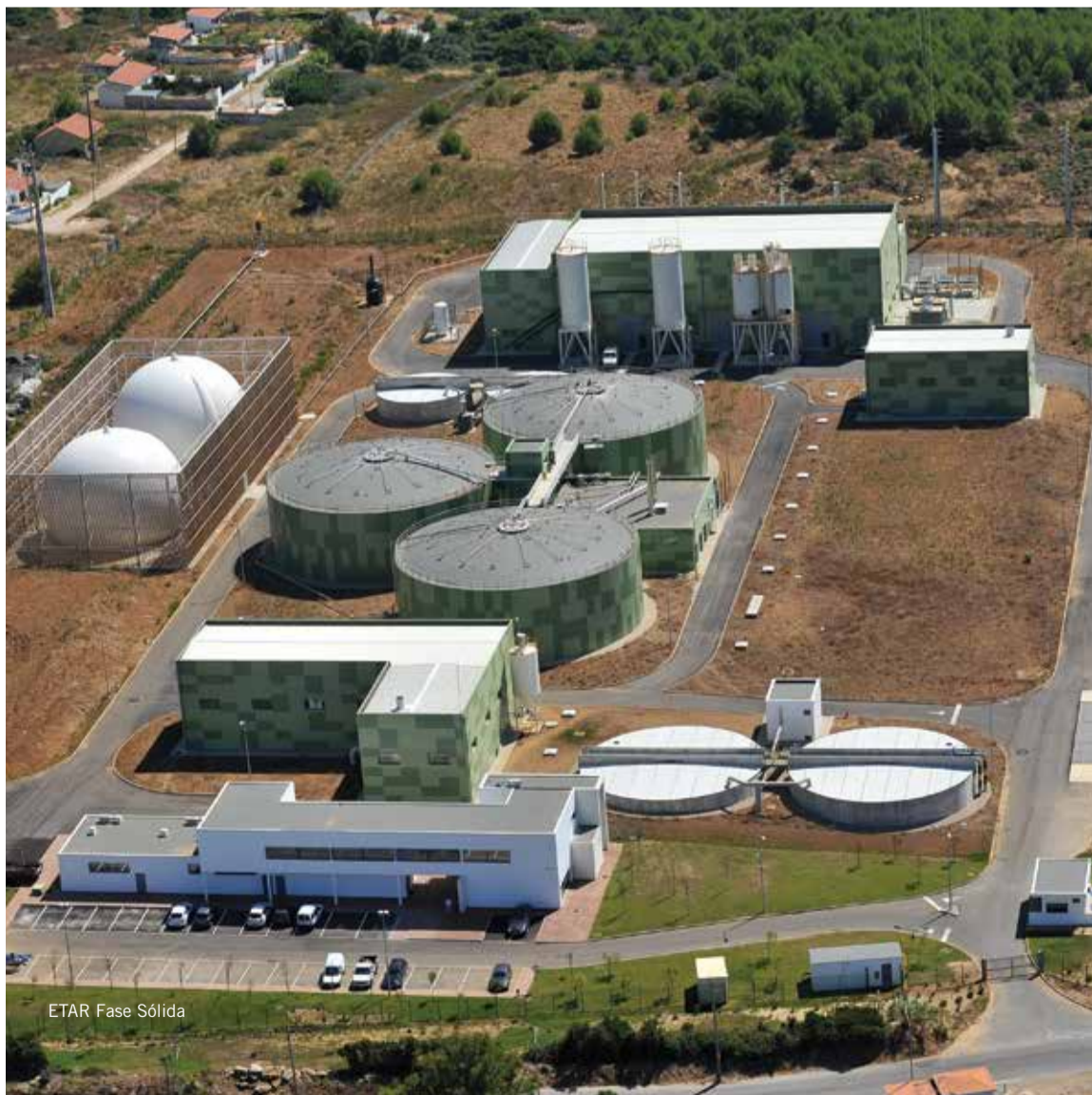
ETAR, edifício antigo e edifício recente (Fase Líquida)
