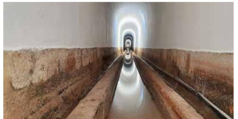
Interior da galeria do aqueduto sobre o Vale de Alcântara: “Dentro existe uma galeria abobadada, que corre ao longo de toda a linha interior do aqueduto, oferecendo constantemente o ar do interior do edifício um espaço livre para aí trabalharem os indivíduos encarregados da colocação das calhas, limpeza dos canais e melhoramento das obras de alvenaria”. F. Lichnowsky
