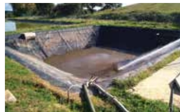
Limpeza de lagoa com recurso a hidroaspirador
