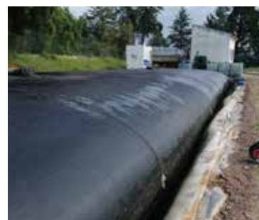
Limpeza de lagoa com recurso a saco drenante para desidratação
