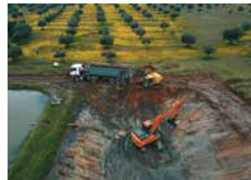
Limpeza de lagoa anaeróbia por secagem solar
