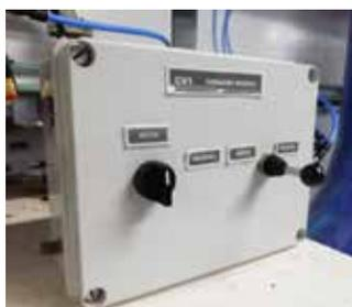
O sistema QuickAct consiste num módulo pneumático para controlo expedito por parte da equipa de operações sobre a válvula de regulação de nível de cada Filtro de uma ETA.
