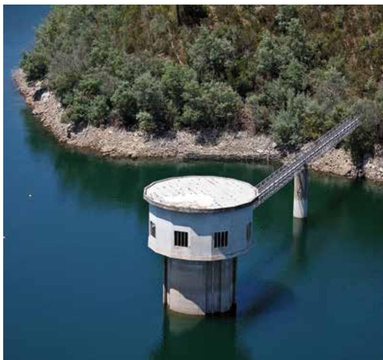
Foi efetuada, em 2020, a inspeção subaquática à Torre de Captação de Castelo do Bode e ao pilar de suporte do passadiço de acesso à respetiva plataforma de manobras. Esta inspeção decorre do plano regular de inspeções a esta infraestrutura, de modo a acompanhar a evolução do seu estado de conservação e a identificar eventuais situações que careçam de intervenção.
