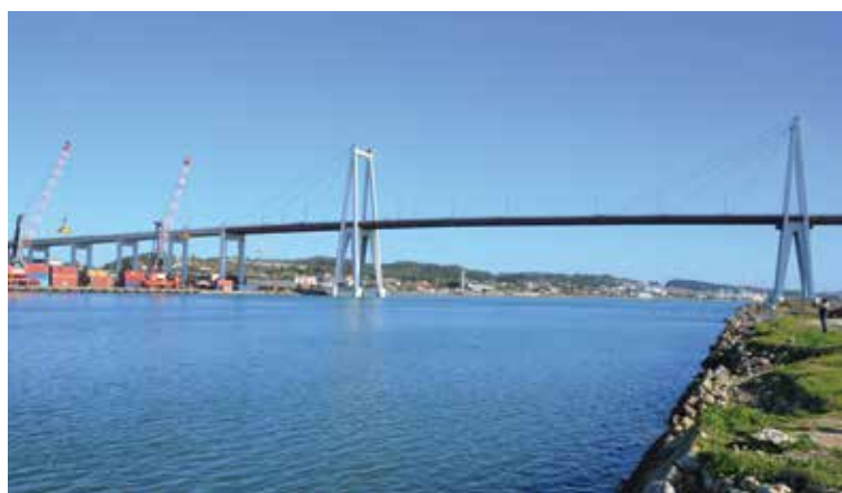
Ponte Edgar Cardoso sobre o rio Mondego, inaugurada em 1982, é um dos ex-libris da cidade da Figueira da Foz. Foi a primeira ponte rodoviária realizada em Portugal com o tabuleiro atrintado.
