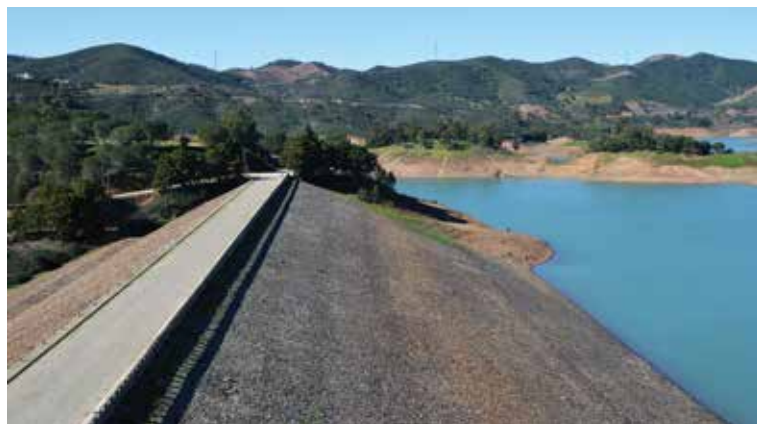
Construída em terra, a barragem do Arade tem uma altura de 50 metros. A sua albufeira tem uma capacidade total de armazenamento de água de 28,5 milhões de metros cúbicos
