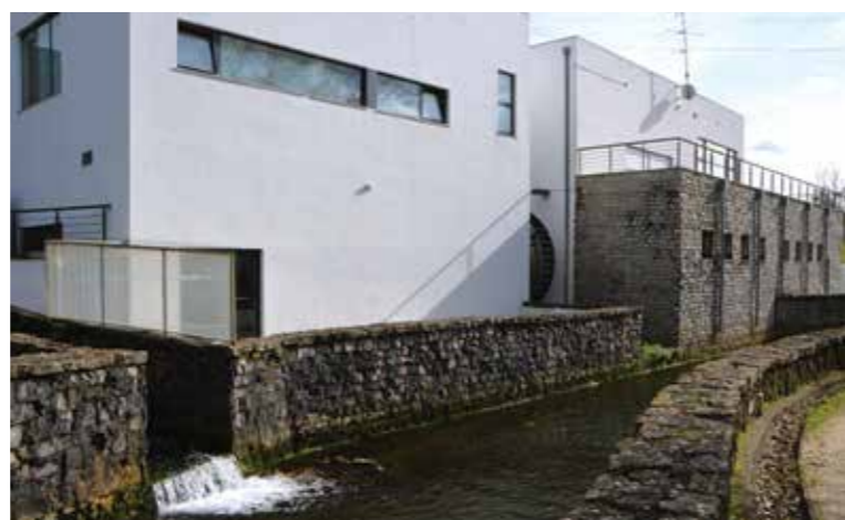
Próximo das nascentes dos Olhos d'Água, em Ansião, foi inaugurado, em 2008, o Centro de Interpretação da Nascente do Rio Nabão. Este edifício resultou da recuperação de um antigo lagar de azeite.
