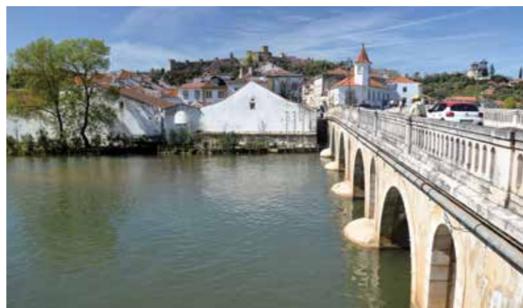
Esta antiga travessia, construída com pedra calcária, assenta sobre seis arcos de volta perfeita. Na primeira metade do século XX, foi totalmente remodelada, tendo sido alargada e reconstruídas novas guardas, que permitiu estabilizar os seus pilares e contrafortes.
