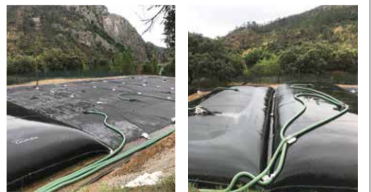
Sistema de floculação associado a sacos drenantes especialmente concebidos para assegurar a retenção da fração sólida e a sua subsequente desidratação
