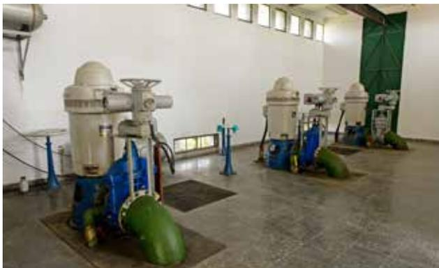
**Figura 1.27** Sala da central elevatória com três bombas, uma para cada poço de chegada da água do artesanismo
