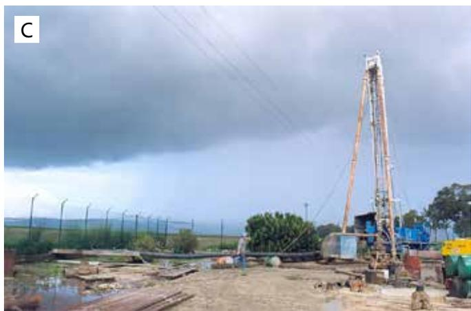
**Figura 4.70** Imagens da construção dos novos furos em Lezíria II: descida de um troço soldado de tubo ralo de fenda contínua em aço inoxidável (A), pormenor do tubo ralo (B) e máquina de perfuração Salzgitter RC8 e desenvolvimento do furo com ar comprimido (C) (fotos do autor)
