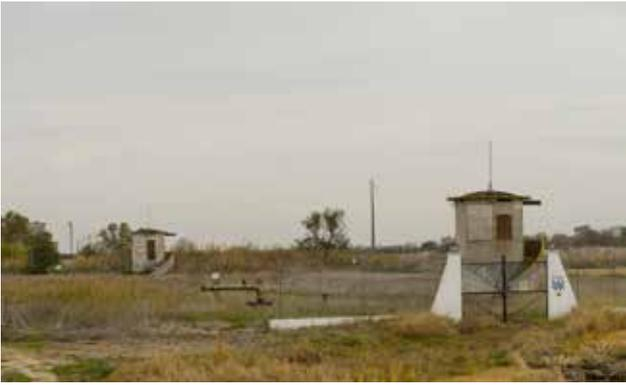
**Figura 1.15** Entrada do campo de captações de Espadanal com as casetas, soerguidas em relação à superfície do terreno, de dois furos de captação no sistema aquífero aluvionar do Tejo. É também visível a cabeça de um furo, com parte da tubagem de elevação, que capta nas formações do sistema aquífero terciário (ACP500-1)
