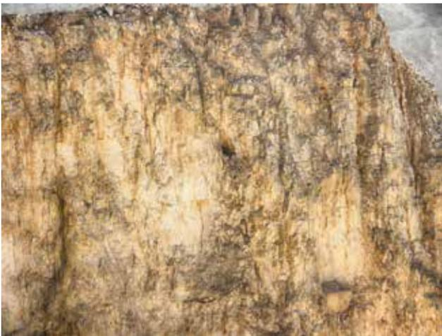
Figura 5.23 Frente de desmorte de uma pedra com uma galeria de pequeno diâmetro perto da superfície, associada a fraturação sub-vertical (foto do autor)
