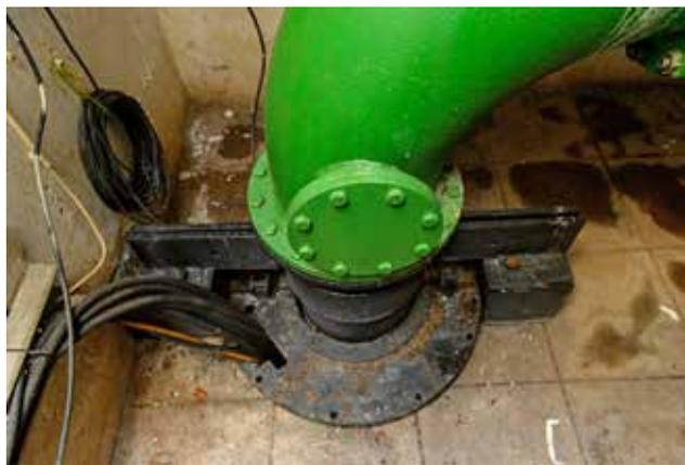
**Figura 1.19** Furo de captação de Alenquer em caseta enterrada e equipado com uma eletrobomba submersível
