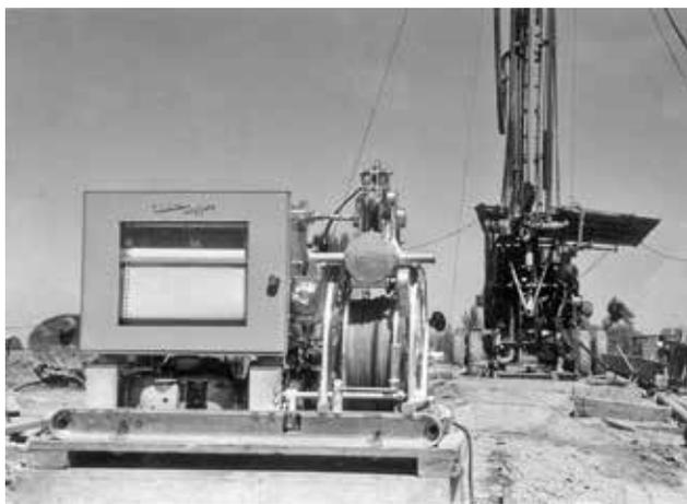
**Figura 4.13** Aparelho WIDCO para diagrfias elétricas em furos. Foto ACAVACO / Imagens cedidas por EPAL-CDHT
