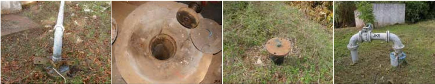
**Figura 2.11** Furos do campo de captação de Olhos de Água de Aramenha da empresa AdVT (fotos do autor)
