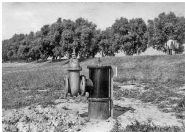
**Figura 4.21** Cabeça do furo AC-MP5 (Quinta do Lezirão) Foto ACAVACO / Imagens cedidas por EPAL-CDHT
