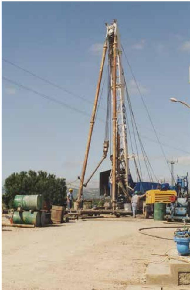
**Figura 4.68** Máquina de perfuração Salzgitter RC8, executando um furo de reposição pelo método de circulação inversa
