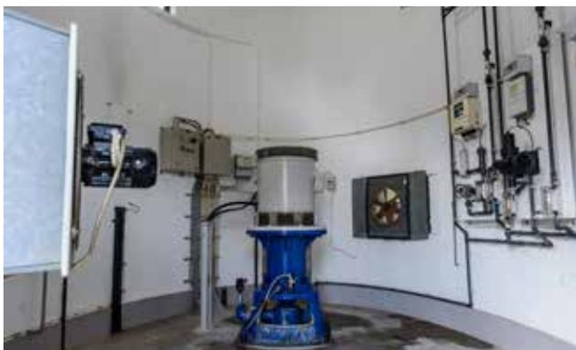
**Figura 1.21** Interior da caseta do furo de captação ACP2 de Ota com motor da bomba de eixo vertical e equipamento elétrico e de controlo da exploração
