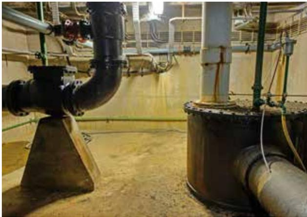
**Figura 1.26** Central elevatória da água dos furos artesanais de Valada I: poço de chegada e de bombeamento da água de uma das captações; conduta do furo para o poço de chegada (conduta horizontal), coluna de elevação da bomba (vertical sobre o poço de chegada) e conduta adutora para o canal Tejo com cotovelo de 90°
