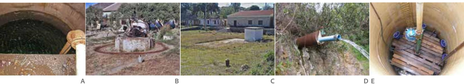
**Figura 2.7** Poços e furos no maciço antigo: poço (A), poço com nora (B), furo vertical (C), furo horizontal (D), poço com drenos horizontais em aluviões do Mondego (E) (fotos do autor)
