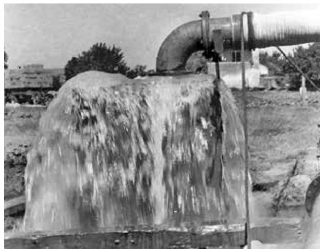
**Figura 1.24** Furo AC-ME3 (Valada) com artesianismo repuxante de 70 L/s (foto ACAVACO)
