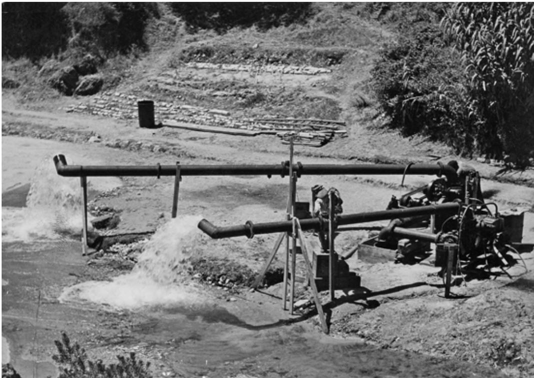
**Figura 5.43** Ilustração do equipamento e das condições de realização dos ensaios de produtividade dos furos de captação de Ota (in Oliveira, 1956 / Imagens cedidas por EPAL-CDHT)
