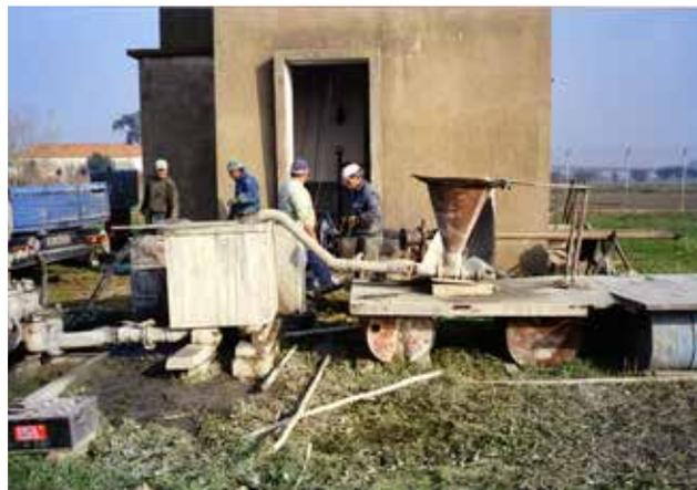
**Figura 1.23** Operações relativas à eliminação de uma captação de Lezíria I (foto do autor)
