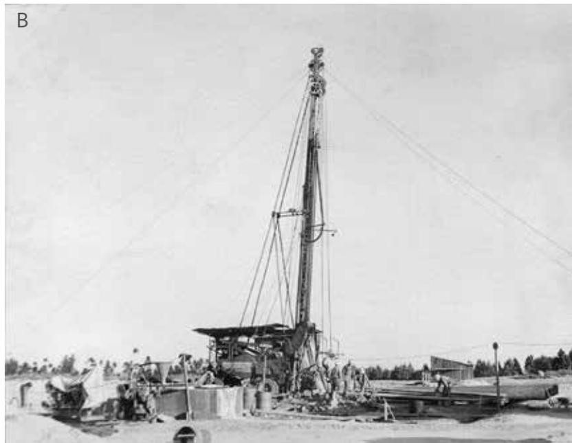
**Figura 4.11** Máquinas de perfuração utilizadas na empreitada: Sonda Salzgitter SW 200 (A) e Sonda Star 72 RP (B)
