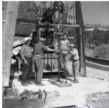
**Figura 5.32** Trabalhos de construção dos furos de captação em Alenquer (in Oliveira, 1956 / Imagens cedidas por EPAL-CDHT)
