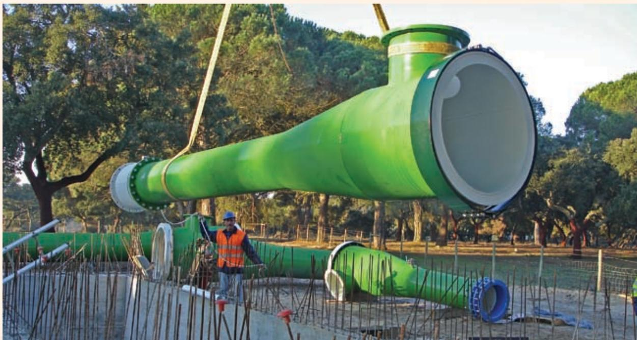
Projecto de macromedição para combate às perdas de água. Instalação de medidores de caudal.
