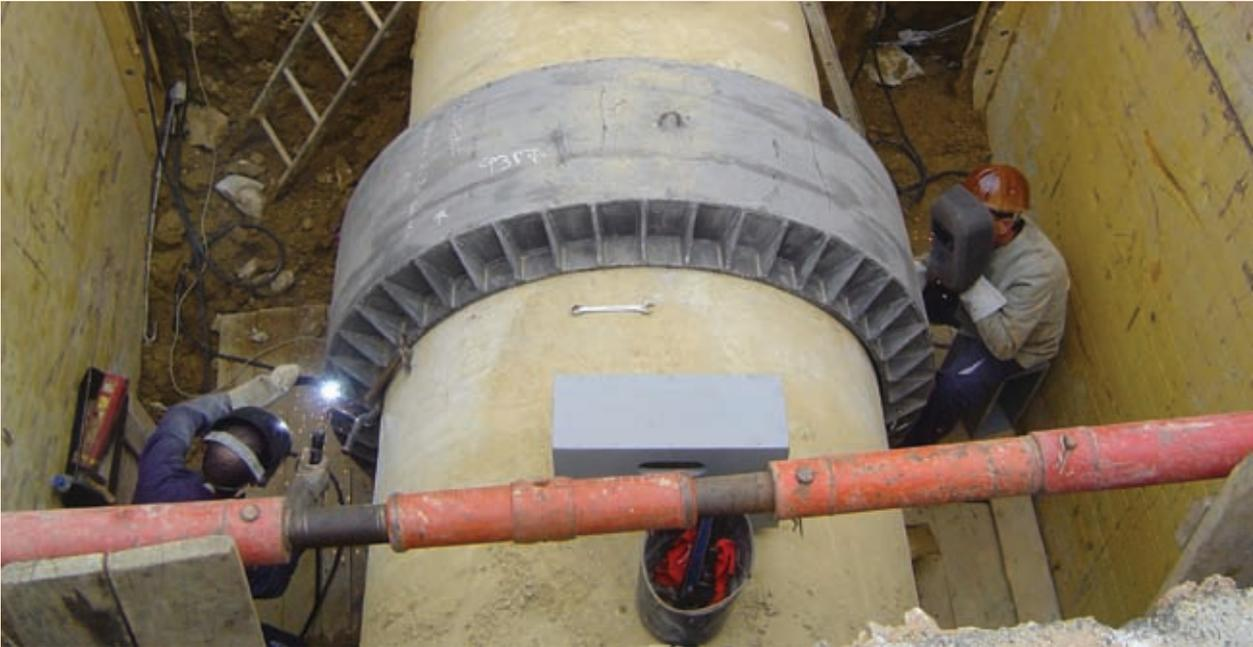
Reparação de conduta de betão armado de Ø 1000 - colocação de anel.
